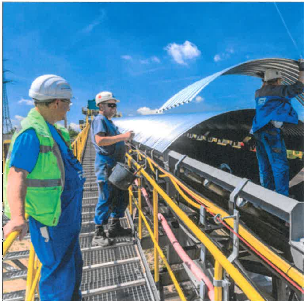
Bau einer Kohlebandanlage
